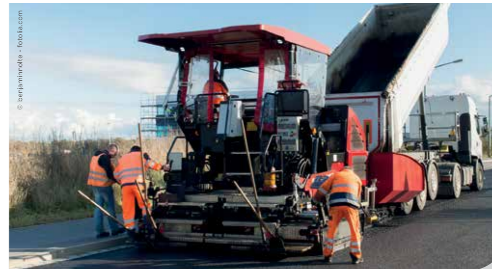
Fahrzeug zur Fertigung von Fahrbahn-Oberflächen, ausgestattet mit templine® Heizschläuchen zur Bitumen-Förderung (220°C)
